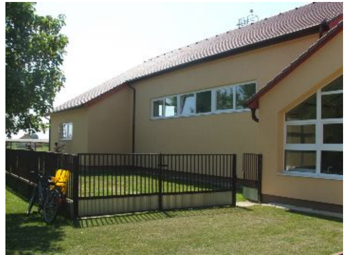
A tornaterem épülete a felújítás után
